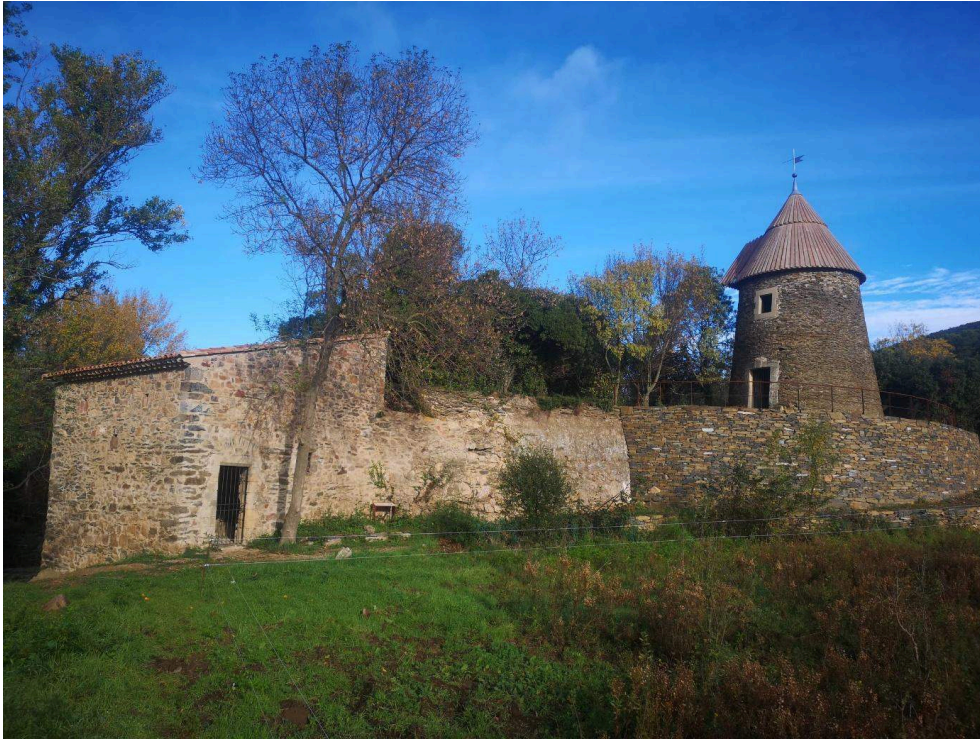
Cabrerolles (Hérault), moulins à eau et à vent de Lenthéric, 2022.
