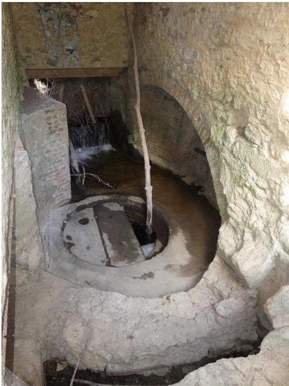
Murviel-lès-Béziers (Hérault), moulin de Réals, roue horizontale à cuve, 2022.
