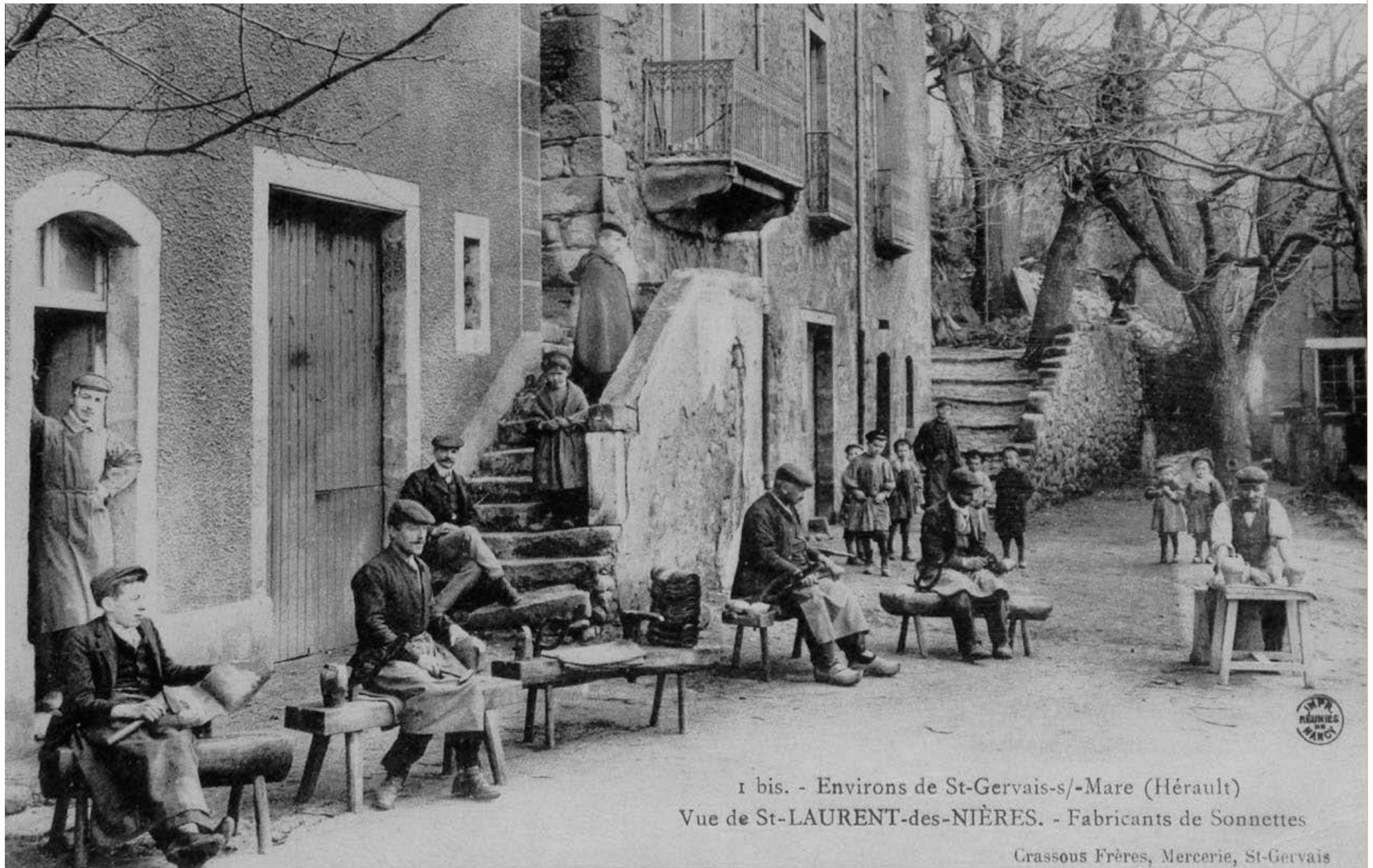
↳ Carte postale « Fabricants de sonnettes », vers 1900. Chaque sonnailler travaille sur un banc dans lequel sont intégrés les outils nécessaires à la mise en forme de la tôle.
