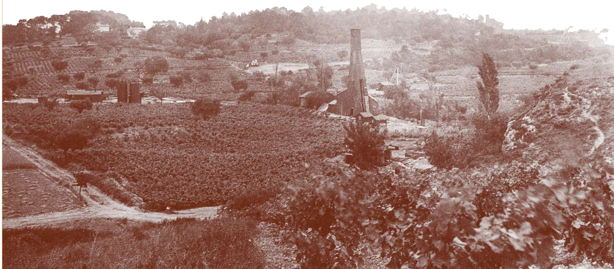
➤ Vue générale du gisement pétrolier de Gabian en 1928. Au second plan, à gauche, le puits n° 1 en exploitation et ses deux réservoirs de stockage. Au centre, le puits n° 33 en cours de forage (coll. Patrick Reeb).
