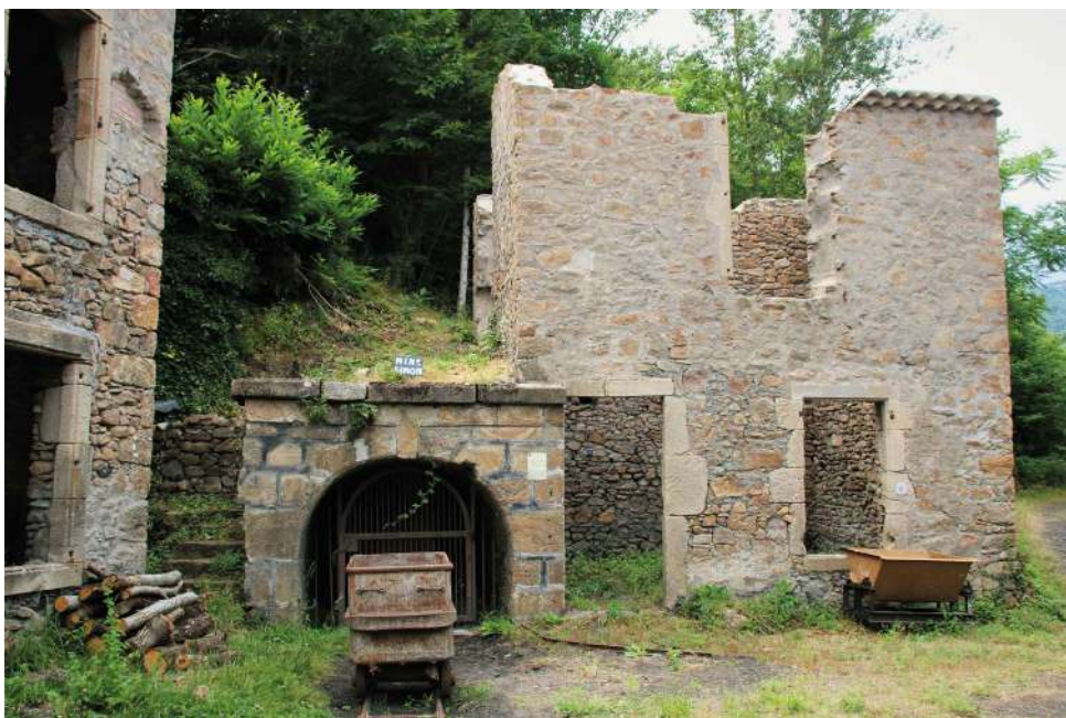
Wagonnets et bâtiments, vestiges de la mine Simon à Graissessac. © F. Renerre / Pays HLV
