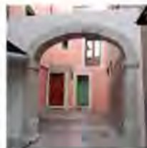
Les arcades après travaux.
