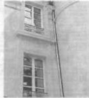
Une façade rénovée à l'enduit à la chaux naturelle.
