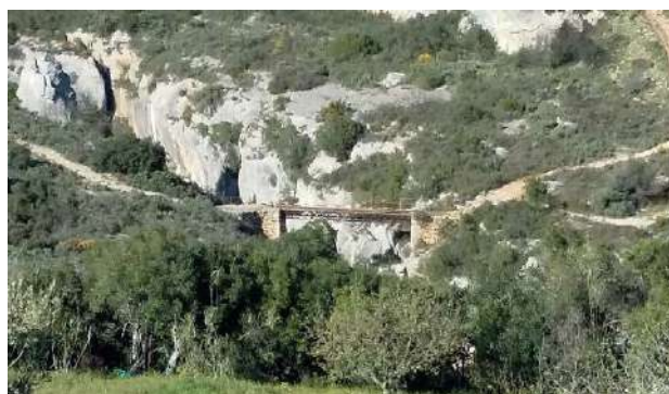
► Passerelle de Coupiac entre Minerve et La Caunette © S. Brisa
