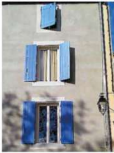
Une façade rénovée.
