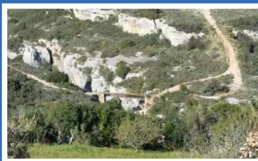
Passerelle de Coupiac entre Minerve et La Caunette © S. Brisa
