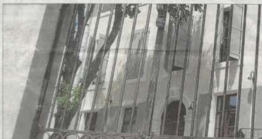
■ La politique menée par le Pays Haut Languedoc et Vignobles a permis de rénover l'habitat.
