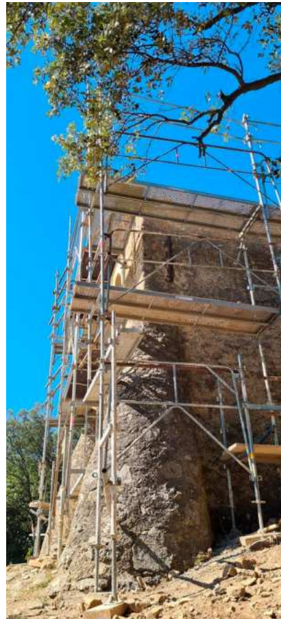
Chapelle Montcèze en travaux © Commune
