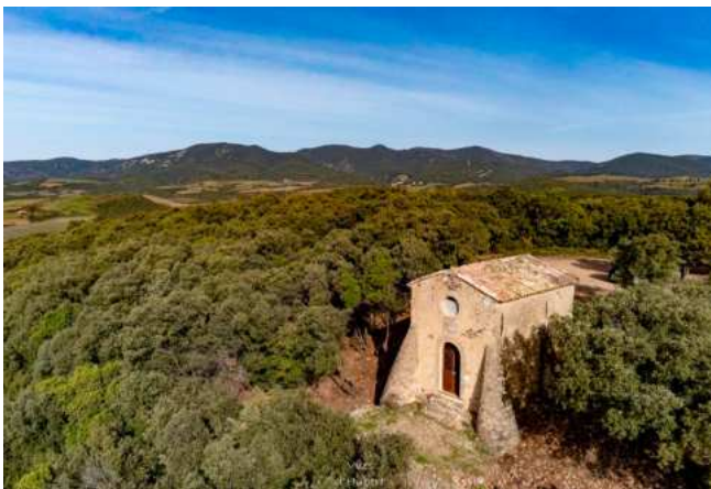
Chapelle Montcèze après travaux © Commune
