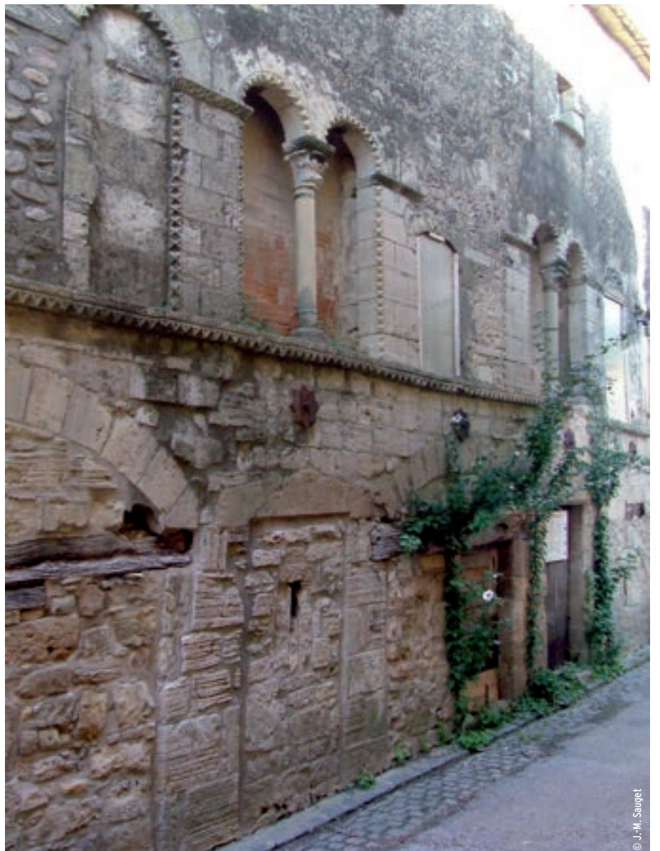
VILLEMAGNE-L'ARGENTIÈRE, HÔTEL DES MONNAIES (XIII e SIÈCLE)
