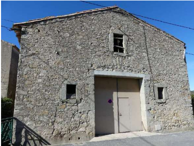
Chai route de La Caunette, arc de décharge en tas de charge / Ancienne porte de bâtiment agricole, rue des Chasseur, arc de décharge en tas de charge sur linteau en bois (remploi d'une vis de pressoir).
