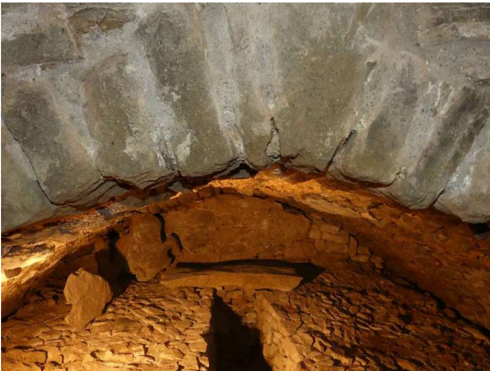
Arche du pont enjambant les anciens fossés, 2021.
