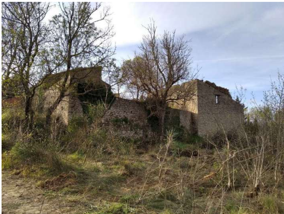
Métairie des Mouleyres, bâtiments ruinés.
