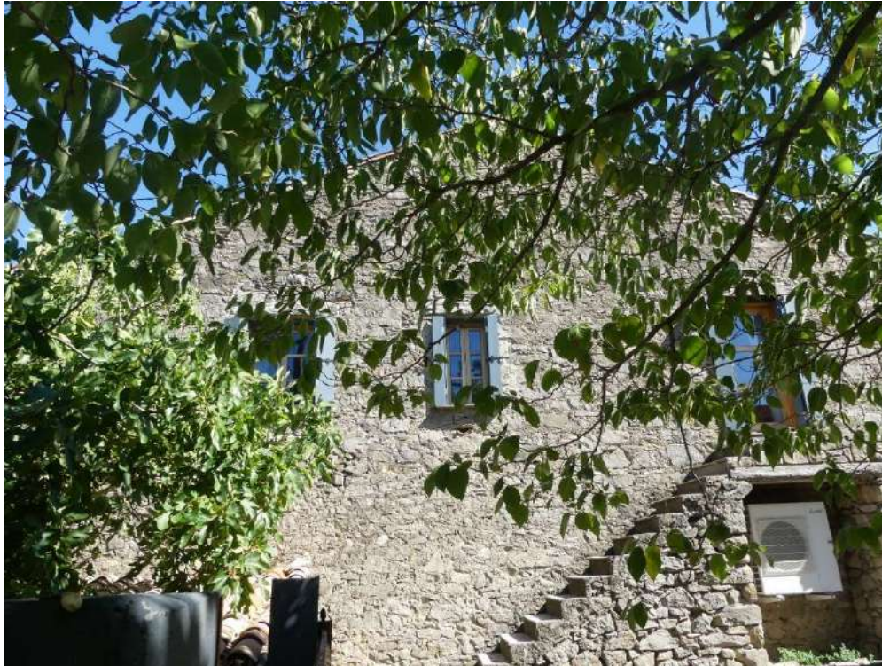
Maison bloc en hauteur : partie agricole en rez-de-chaussée, logis à l'étage accessible par un escalier extérieur contre le mur pignon.
