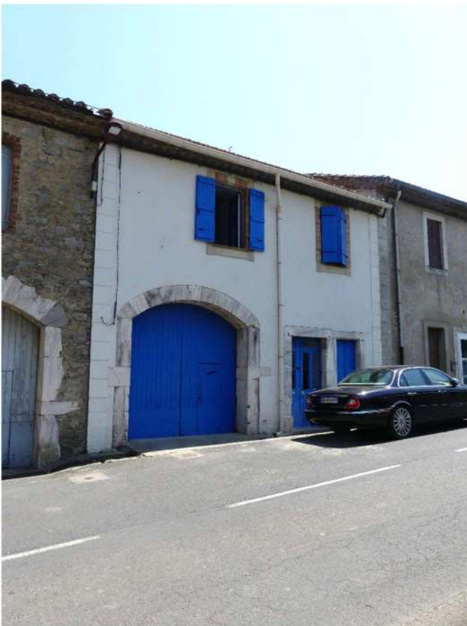
Maison bloc à terre : logis à droite, partie agricole à gauche.
