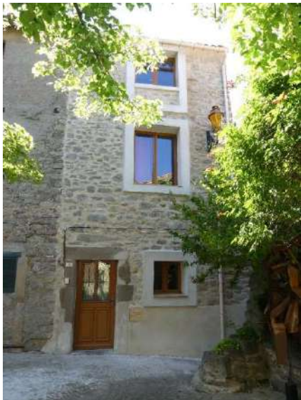
Maison place de l'Eglise, encadrement de porte en grès et encadrements de fenêtres en ciment / Maison route de La Caunette, encadrements mixtes (grès, brique, ciment, tuf).
