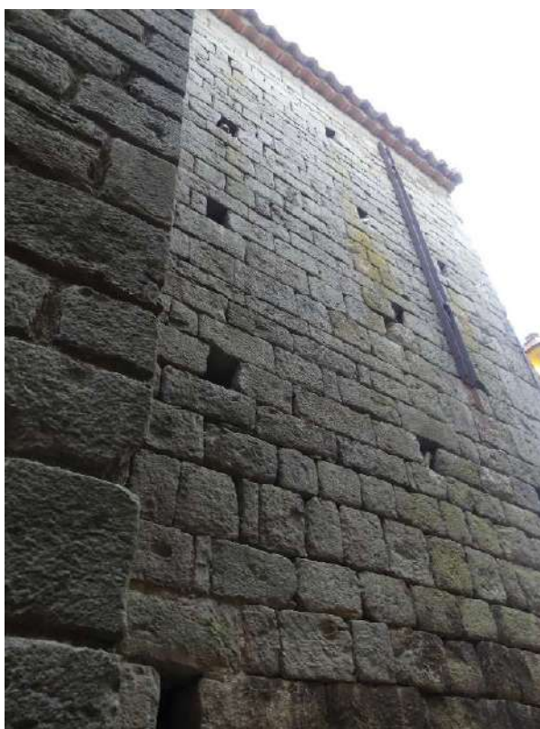
Eglise St-Martin, élévation nord, travée occidentale.
