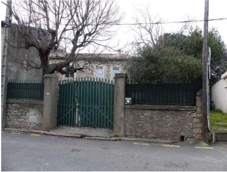
Ramonétage, 3 route de La Caunette.
