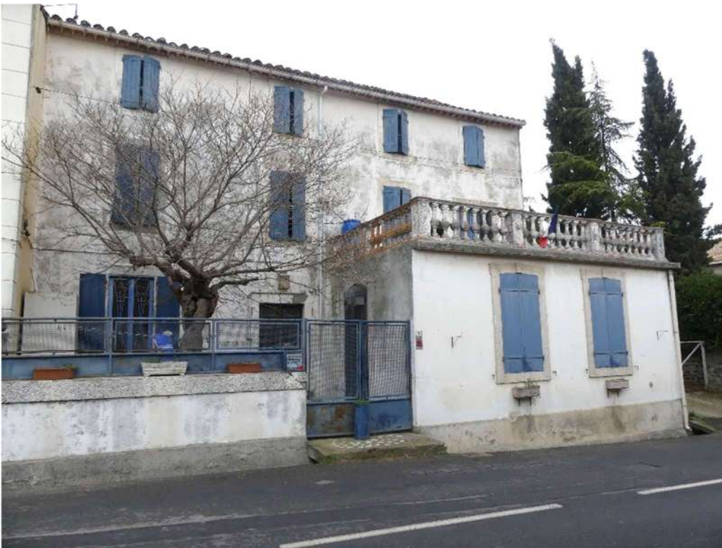
Maison 6 rue des Ecoles, balustrade en terre cuite.
