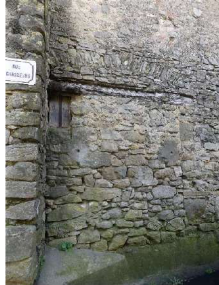
Chai route de La Caunette, arc de décharge en tas de charge / Ancienne porte de bâtiment agricole, rue des Chasseur, arc de décharge en tas de charge sur linteau en bois (remploi d'une vis de pressoir).
