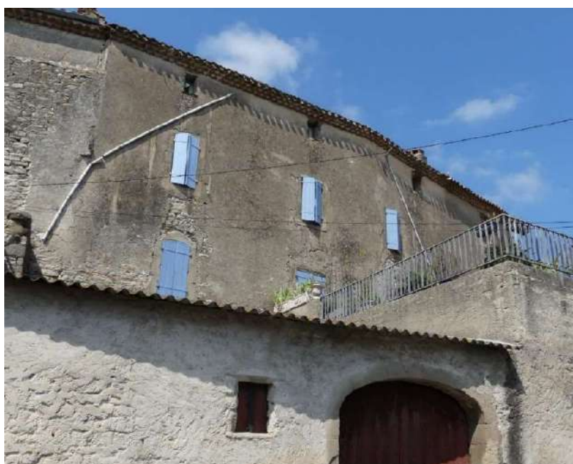
Mur d'enceinte modifié au XVIII e siècle.
