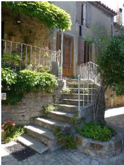
Escalier tournant, maison 3 place de l'Eglise
