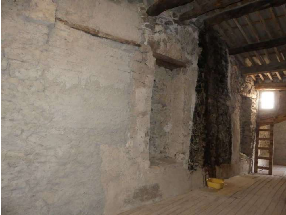
Portes de communication inter combles murées.
