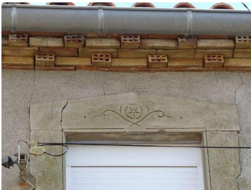
Maison 12 route de La Caunette, détail de la corniche en brique creuse.
