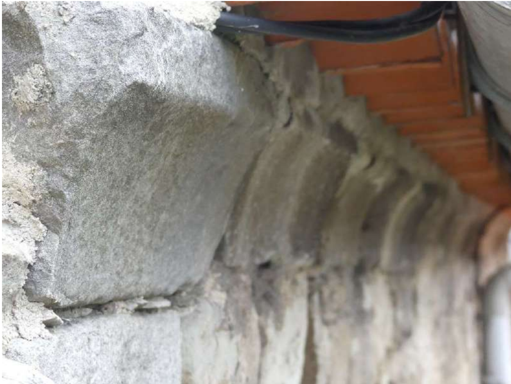
Eglise St-Martin, bas-côté, élévation sud, corniche en cavet.
