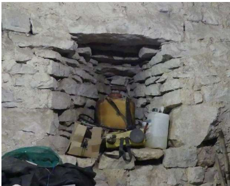
Elévation intramuros , archère (parcelle A137).
