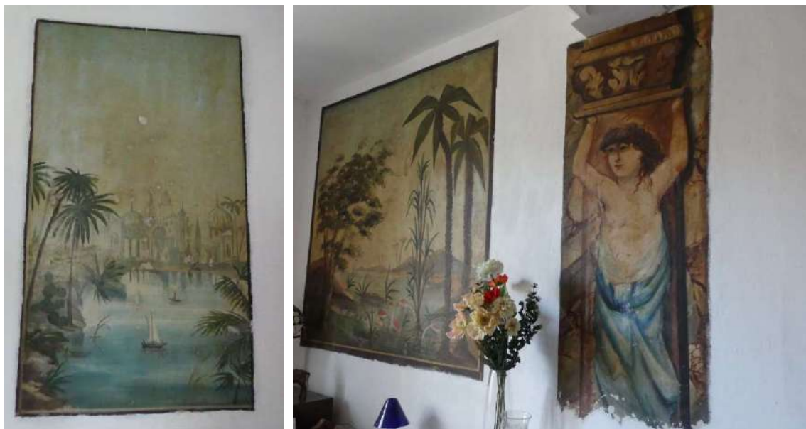
Maison 34 rue Saint-Martin, état actuel des peintures murales.
