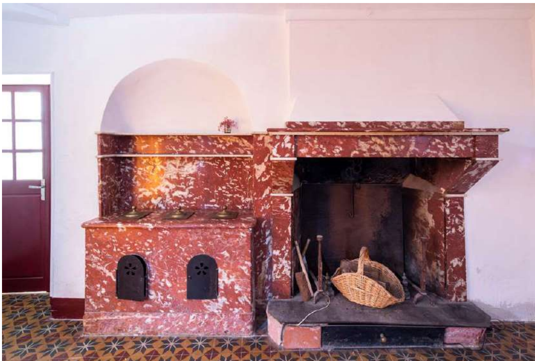
Cheminée et potager en marbre de Caunes dans une maison rue des Fossés, XIX e siècle. ©Amélie Boyer, Inventaire général Région Occitanie, 2021.
