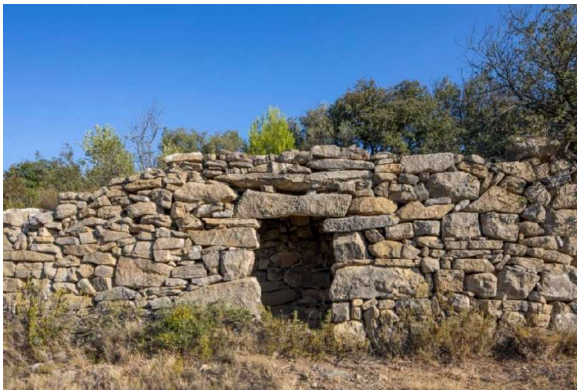
Cabane aménagée dans un mur en maçonnerie de pierres sèches, Sainte-Léocadie. ©Amélie Boyer, Inventaire général Région Occitanie, 2021.
