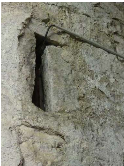
Elévation extramuros , archère (parcelle A 135).
