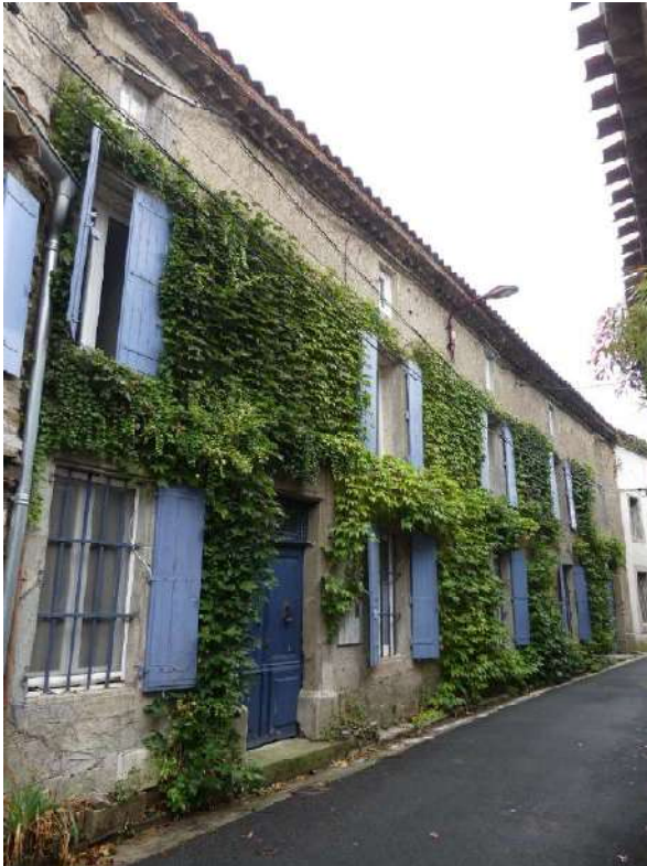
Maison 4 rue des Fossés, corps de logis en front de rue.
