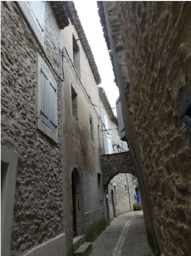
Maison bloc en hauteur : le logis est situé au 1er étage, entre les parties agricoles.
