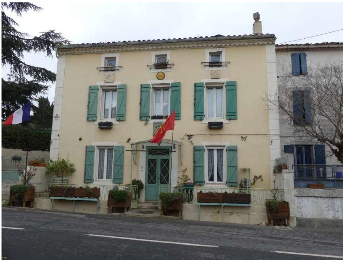
Maison 8 rue des Ecoles.
