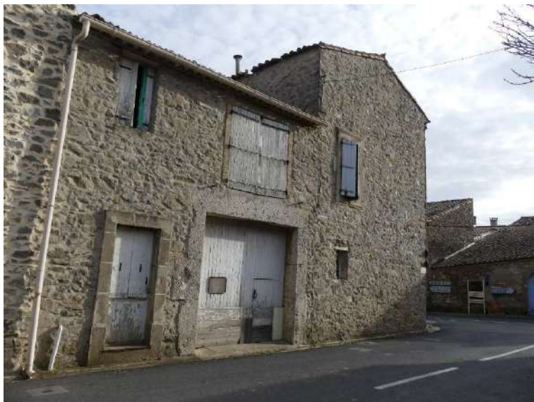
Maison place de l'Eglise, encadrement de porte en grès et encadrements de fenêtres en ciment / Maison route de La Caunette, encadrements mixtes (grès, brique, ciment, tuf).
