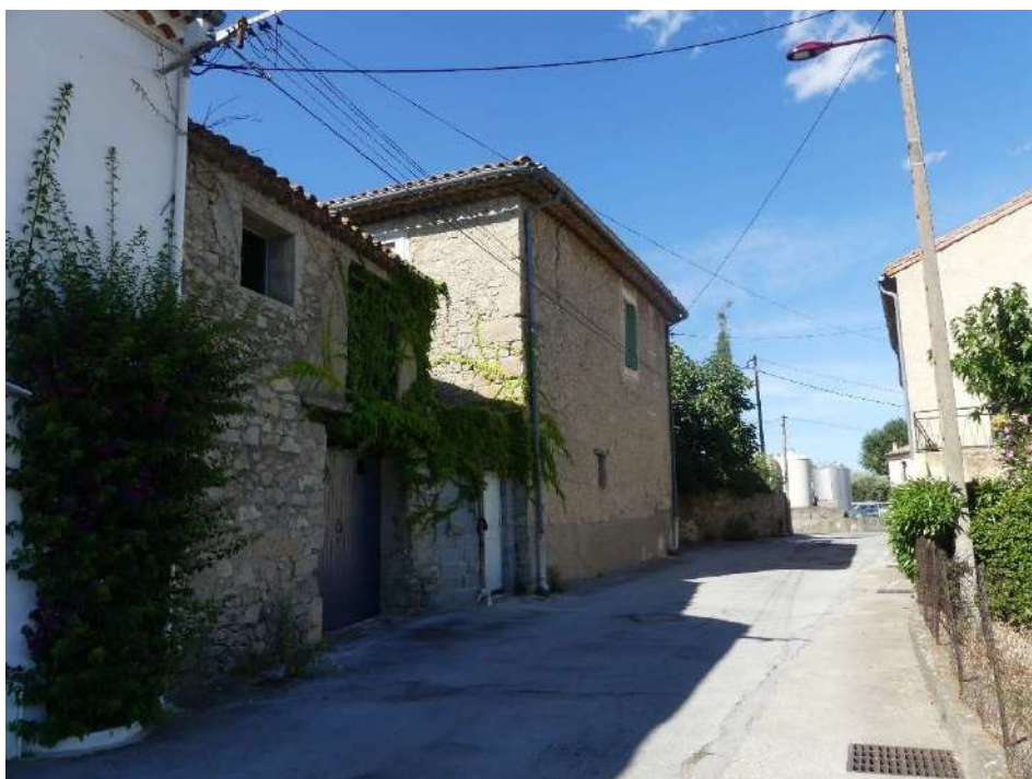
Maison 4 rue des Jardins : élévations latérales et postérieures. Le bâtiment à gauche servait d'écurie et de fenil.
