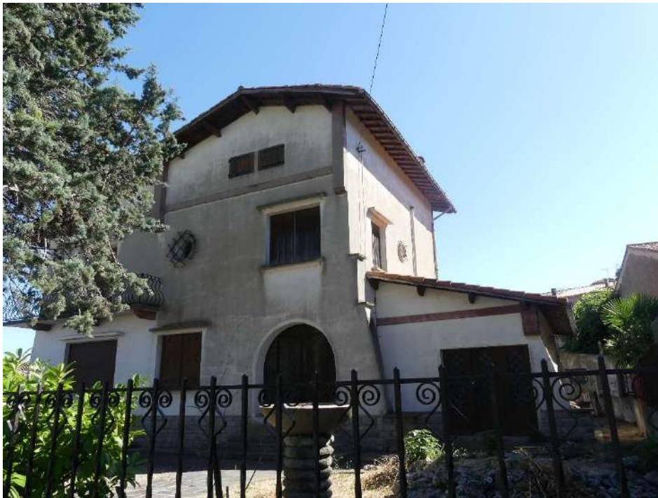
Pavillon des années 1970, 18 rue du Minervois.
