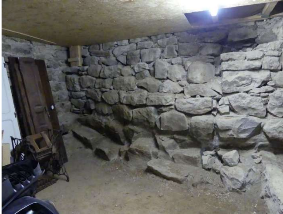
18 rue des Fossés, mur de soutènement et banc de grès.
