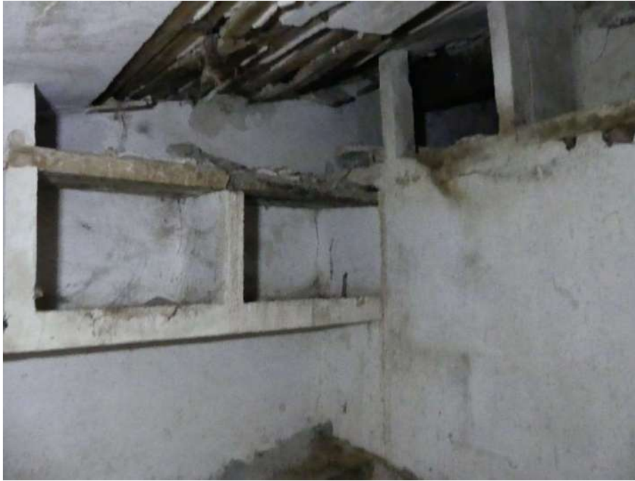
Maison 16 rue Saint-Martin, aménagement intérieur du pigeonnier.
