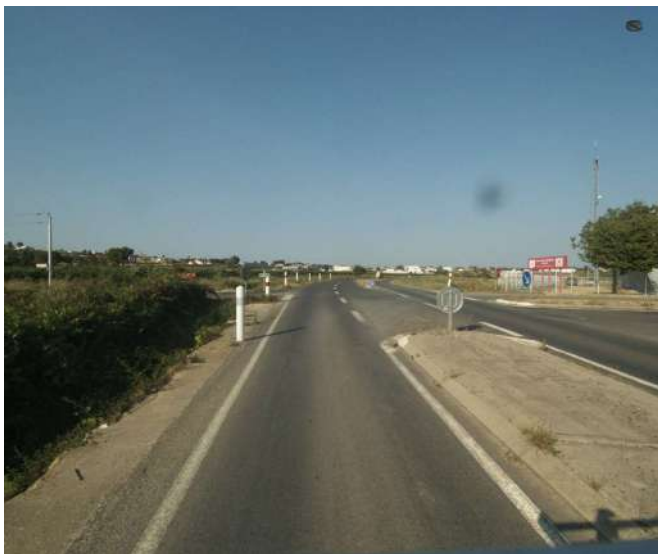
Carrefour caserne de sapeurs pompiers – Accès Passa Païs
