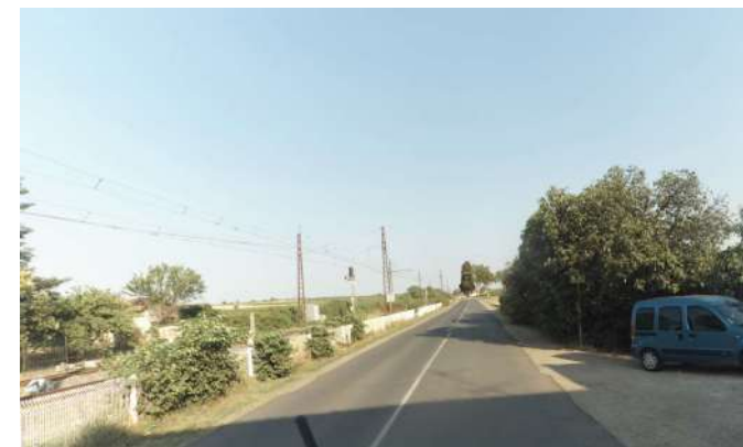
Entrée à Magalas par la D18 et vers la gare et le centre-ville
